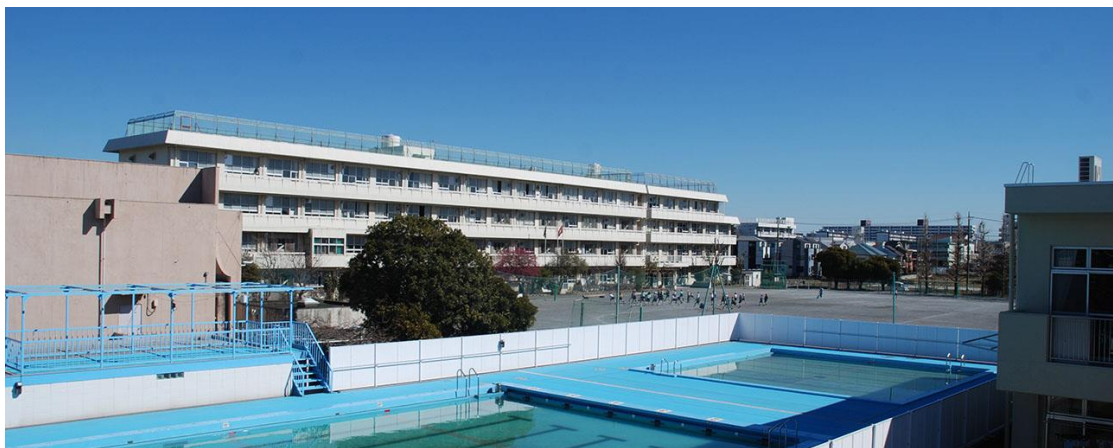
避難所となっている府中市立小柳小学校
