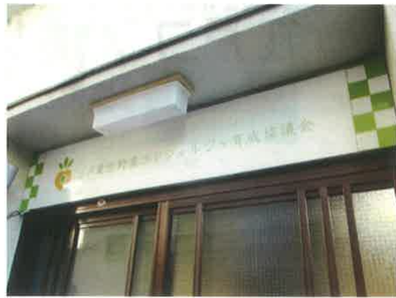
事務所出入口
