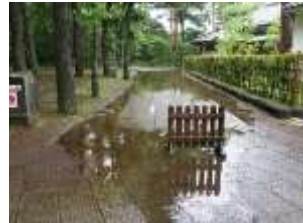
雨水により歩行不可 となった園路
