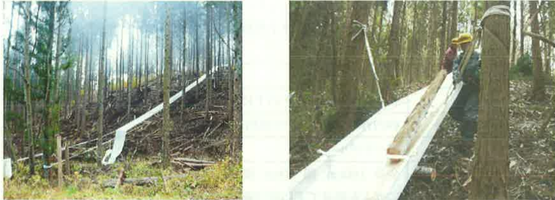
図表 31 架設された SWC の様子 (左) と SWC への間伐材の投入 (右)
