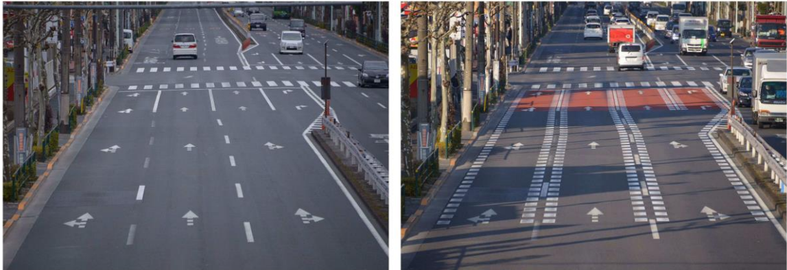
図 10 減速マークの設置例（左：設置前 右：設置後）
